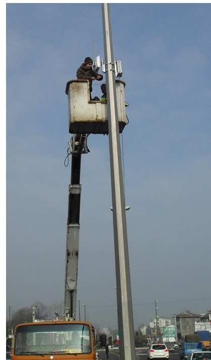
تصاویر ۲ و ۳ - نحوه استقرار و موقعیت نصب RSU بر روی تیر روشنایی
