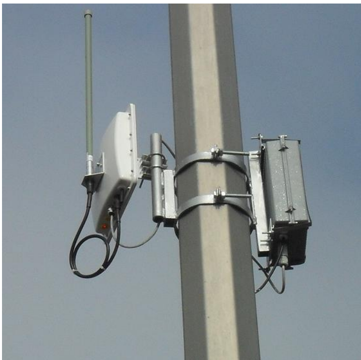
تصاویر ۲ و ۳ - نحوه استقرار و موقعیت نصب RSU بر روی تیر روشنایی
