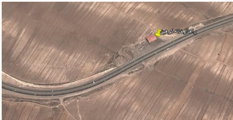
شکل ۱ - موقعیت مکانی ساختمان راهدارخانه گردنه کوهین در آزادراه قزوین - رشت
