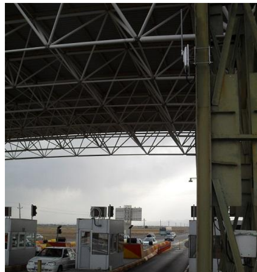
شکل ۲ - نحوه نصب RSU بر روی سازه فلزی محل ایستگاه اخذ عوارض سمت قزوین در آزادراه قزوین - رشت
