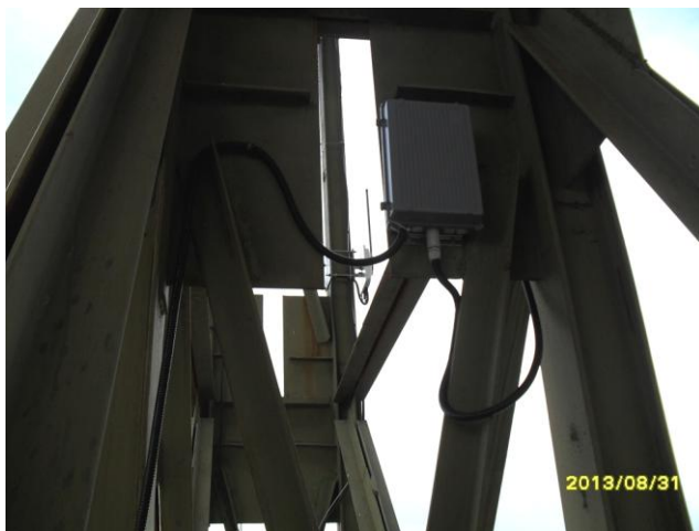
شکل ۲ - نحوه نصب RSU بر روی سازه فلزی محل ایستگاه اخذ عوارض سمت قزوین در آزادراه قزوین - رشت
