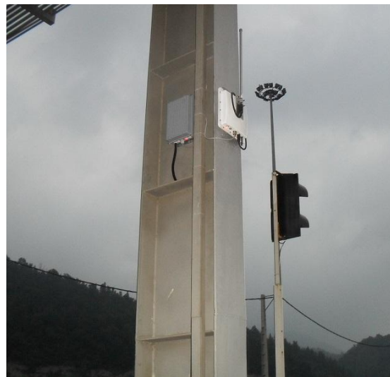
شکل ۲ - نحوه نصب RSU بر روی سازه فلزی محل ایستگاه اخذ عوارض امامزاده هاشم در آزادراه قزوین - رشت
