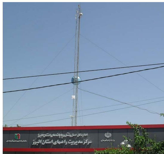
شکل ۲ - نحوه نصب RSU بر روی دکل واقع بر بام ساختمان مرکز مدیریت راه‌های استان البرز
