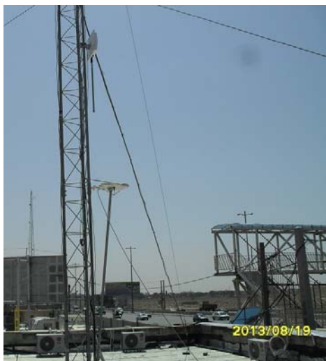
شکل ۲ - نحوه نصب RSU بر روی دکل واقع بر بام ساختمان مرکز مدیریت راه‌های استان البرز
