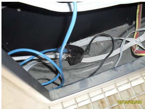
شکل ۴ - تأمین برق و انتقال داده بین RSU و تابلو VMS
