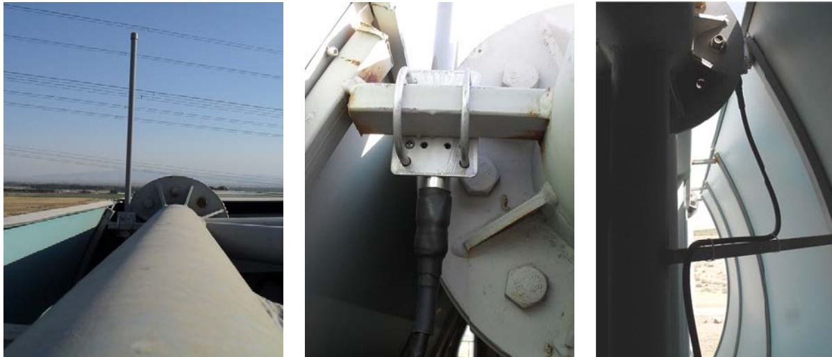
شکل ۱ - نحوه نصب آنتن RSU بر روی تابلوی VMS مستقر در نظرآباد استان البرز
