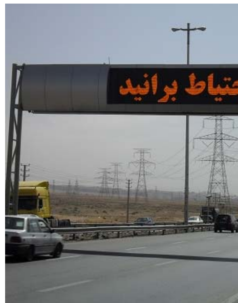
شکل ۳ - نمای تابلوی VMS نظرآباد پس از نصب RSU بر روی آن
