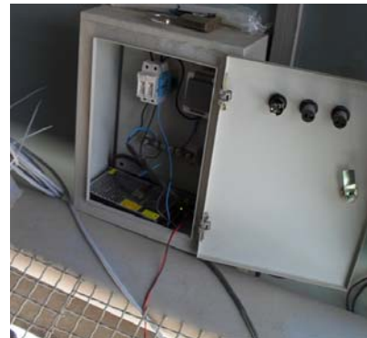
شکل ۴ - تأمین برق و انتقال داده بین RSU و تابلو VMS
